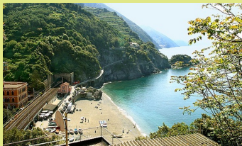
Tratto della linea Genova-La spezia
